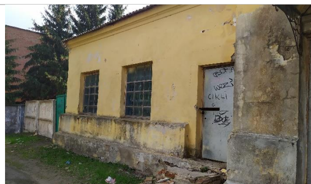
Фотография 3. Фасад здания
