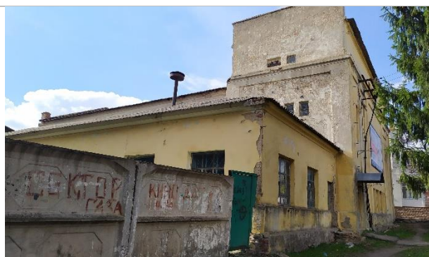
Фотография 4. Фасад здания
